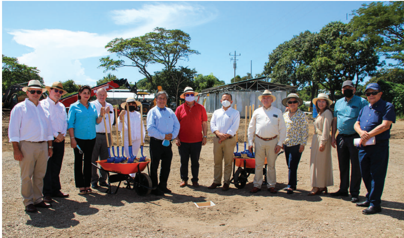
Acto de colocación de la primera piedra del nuevo edificio de Tribunales de Justicia de Puntarenas.
