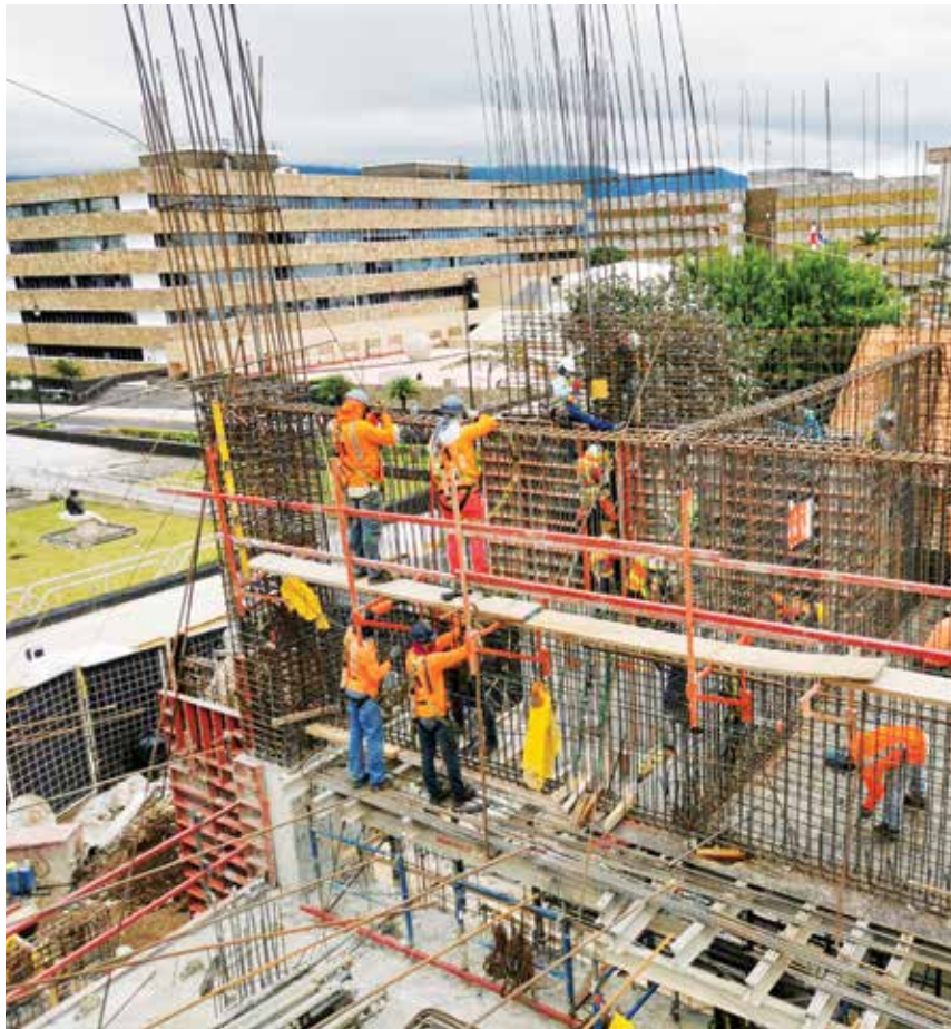
Avance de la construcción del edificio judicial anexo E.
