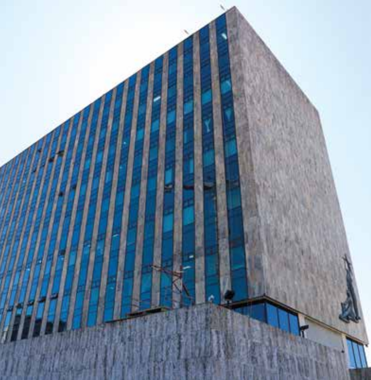
Edificio de la Corte Suprema de Justicia actual, con las mejoras en el sistema de ventanería.
